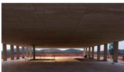
Comisaría de Plasencia , (Arq.: Justo García): Estructura de hormigón postesado con un vano único de 18 metros de luz.
