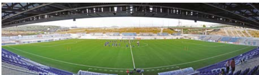
En el El Estadio de Fútbol de Lucena planteamos una estructura singular con una cubierta con grandes luces.
