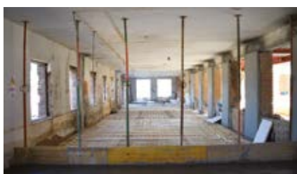
Comisaría de Plasencia , (Arq.: Justo García): Estructura de hormigón postesado con un vano único de 18 metros de luz.
