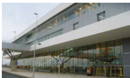
Aeropuerto de Ciudad Real , uno de los primeros proyectos en los que colaboré.
