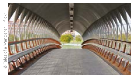
Pasarela Palmas Altas (Arq.: LVA): Estructura de cubierta de la pasarela de acceso al Campus Palmas Altas sobre la SE-30.
