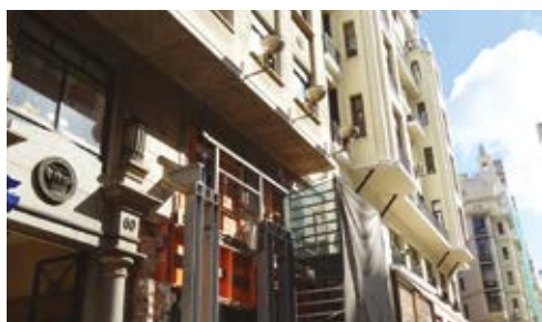
Rehabilitación Gran Vía 60 (Arq. Dedalus): Reposición de pilar de fachada. Edificio protegido.
