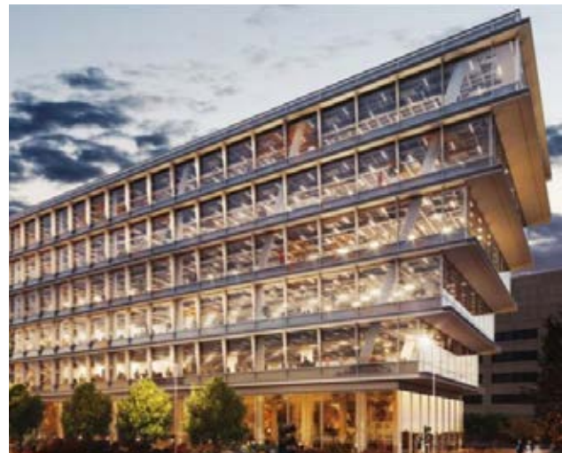
Parque empresarial Monteburgos Avanzan las obras de construcción de este imponente edificio de oficinas situado en Las Tablas, Madrid. Propiedad Tishman Speyer y Metrovacesa Arquitecto BOD Arquitectura e Ingeniería y KPF Estructura Calter
