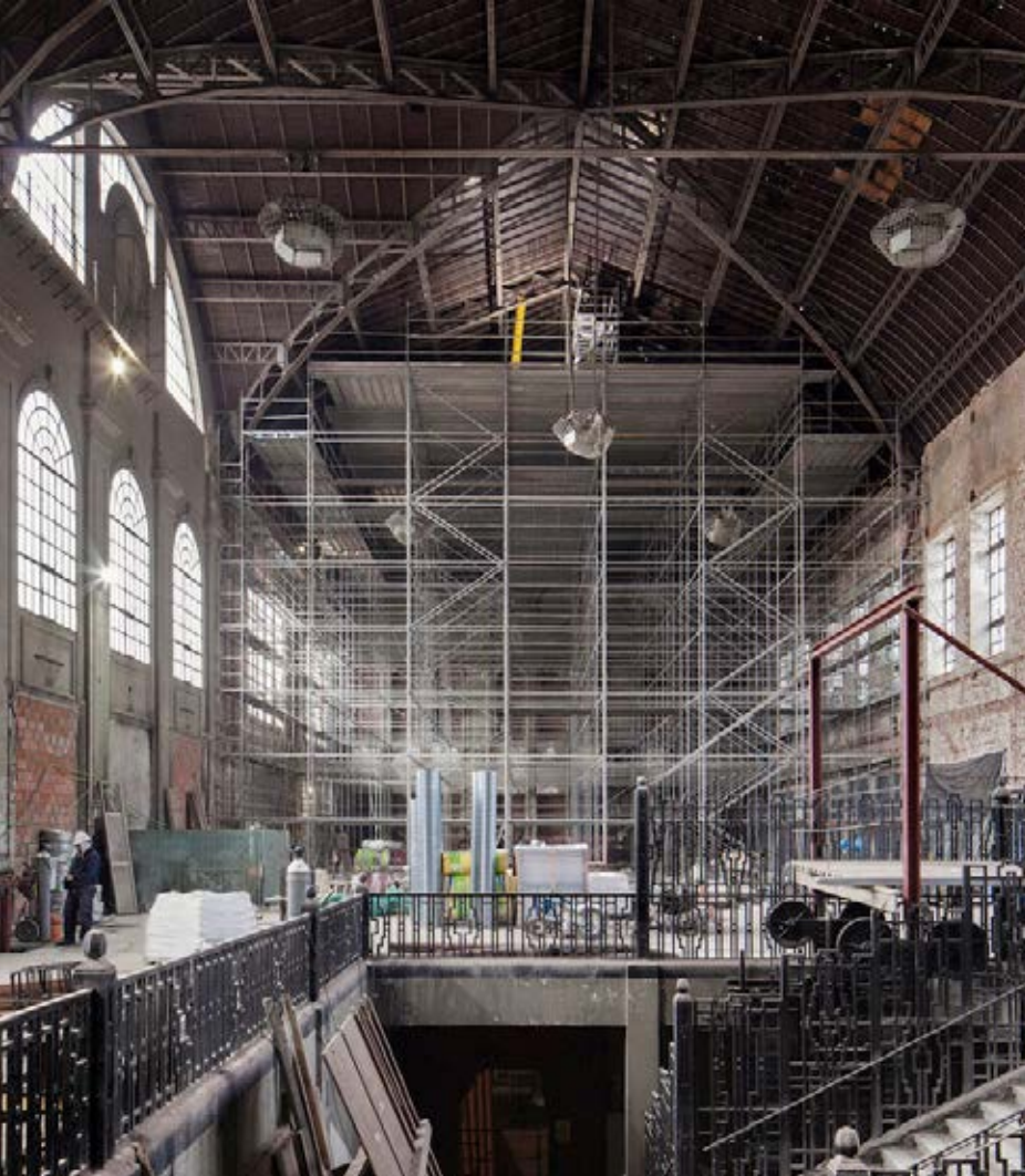
Gran Teatro Bankia Príncipe Pío La pandemia retrasó la inauguración de este soberbio teatro construido a partir de la rehabilitación de un edificio histórico. Propiedad Gran Teatro Príncipe Pío Arquitecto EOS Arquitectos Constructora Solurban Estructura Calter Ver vídeo
